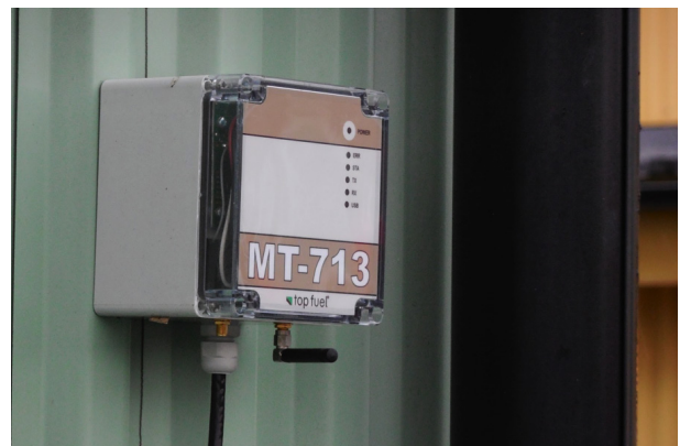
TopFuel datainsamlingsenhet, vid dieseltank hos Swellift
